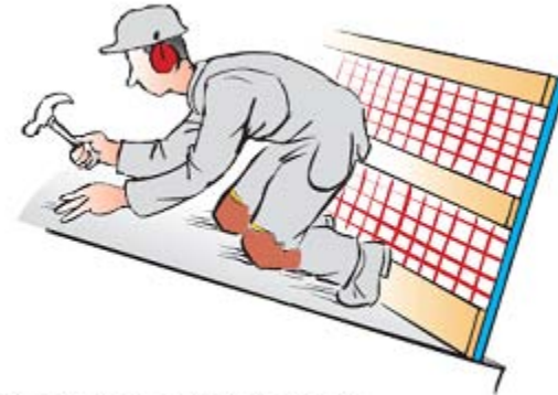
Skyddsräcke vid takarbete.
